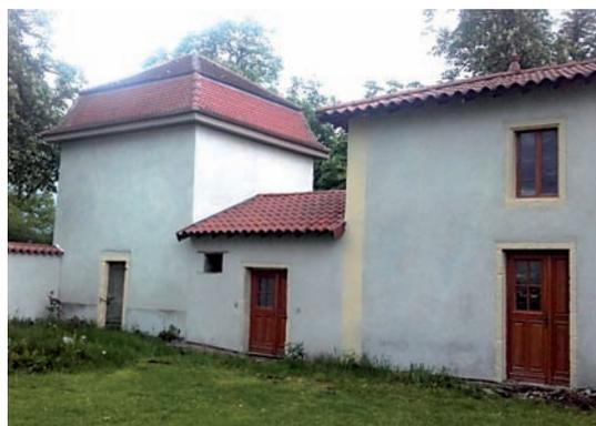
*Demeure, dite château Vergnon (42), construite en pisé, totalement remise à neuf avec des enduits à la chaux et badigeons. Les bâtiments existants sont datables, pour le gros-œuvre, du milieu du 18ème siècle.*
